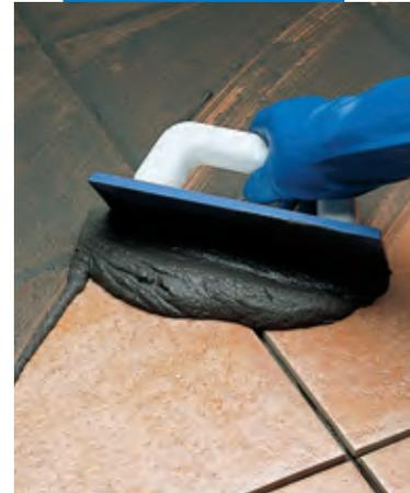
Relleno de boquillas de monococción, con llana
