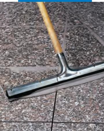
Emboquillado en pisos de granito prepolido, con jalador
